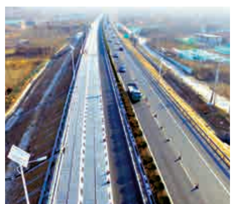
▲高速公路光伏路面鋪設長度為1080米，淨總面積為5875平方米 受訪者提供
