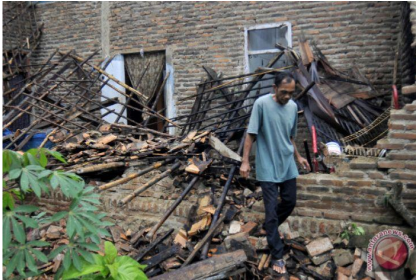
Kerusakan akibat gempa yang terjadi di Lebak, Banten, Selasa (23/1/2018). (ANTARA FOTO/ASEP FATHULRAHMAN)
