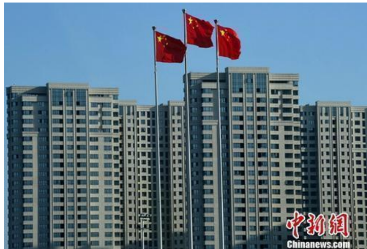
资料图：一处刚建设完工的房地产楼盘。中新社记者 张斌 摄
