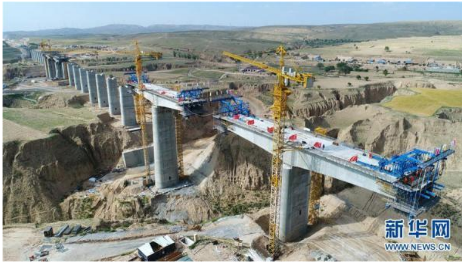
银西高铁甘宁段马坊沟特大桥施工现场（6月23日无人机拍摄），新华社记者王鹏
