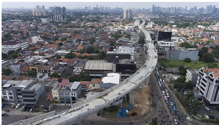
Foto aerial pembangunan proyek jalur layang MRT di Kawasan Fatmawati, Jakarta, 2 Januari 2018.
