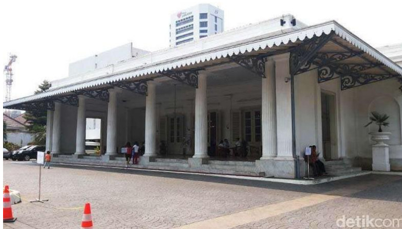
Gedung Balai Kota DKI. (Kurnia Yustiana/detikcom)
