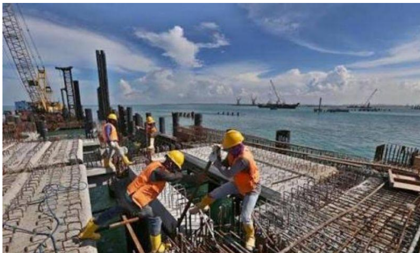
Sumber Foto Istimewa Pekerja dalam proyek pembangunan pelabuhan
