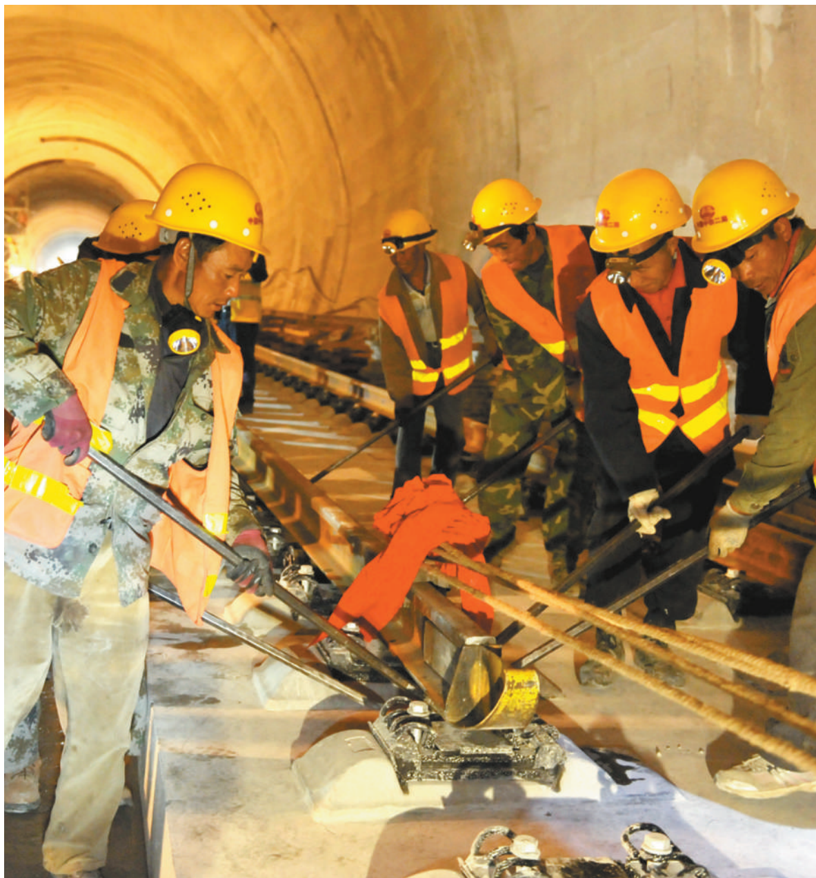
本报昆明4月2日电 (记者杨文明)4月2日,中缅国际通道广大铁路全线铺通,为昆明至大理按计划开行动车奠定了坚实基础。
