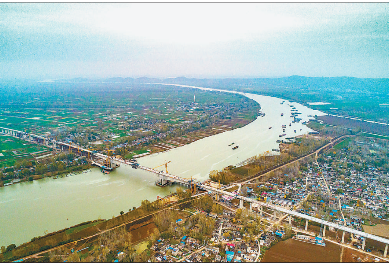
11月18日,新建商丘至合肥至杭州高速铁路重难点控制性工程跨淮河特大桥顺利合龙,大桥全长约17公里。商合杭铁路经过河南、安徽、浙江,是联系江淮与长三角的重要交通干线。 本报记者 史家民摄
