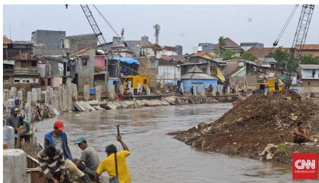
Proyek pembuatan turap kali Ciliwung di wilayah
