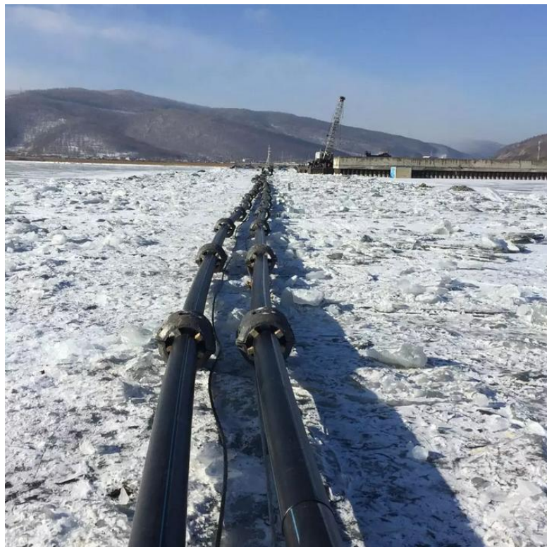
(AquaSib 在贝加尔湖畔修建到一半的工厂和管道)
